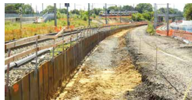
Het nachtelijk plaatsen van vierhonderd lopende meter berlinerwand met stapelplaten was een huzarenstukje.
