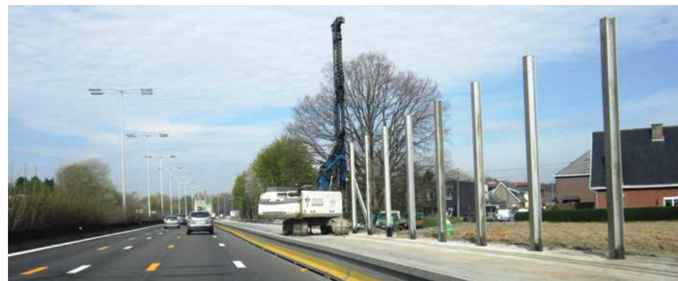
In 2014 was Votquenne Foundations op heel wat autostrades in België aanwezig voor het plaatsen van stalen profielen voor geluidsmuren.
