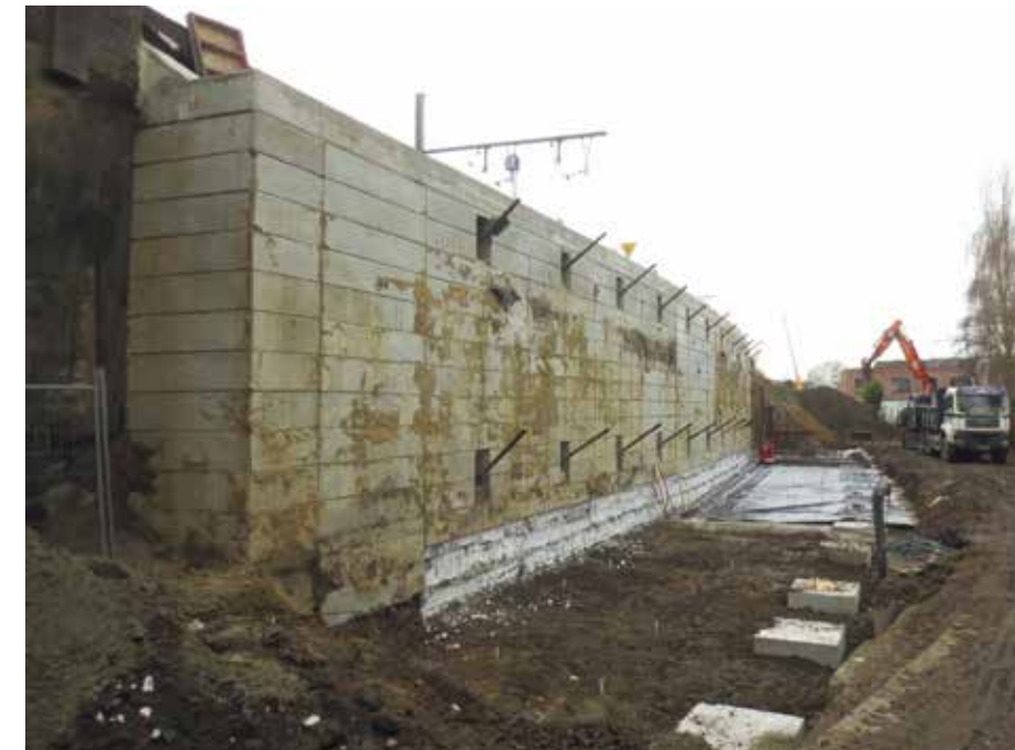
Het was zoeken naar een oplossing waarbij het niet nodig was om definitieve grondankers onder de sporen aan te brengen.
