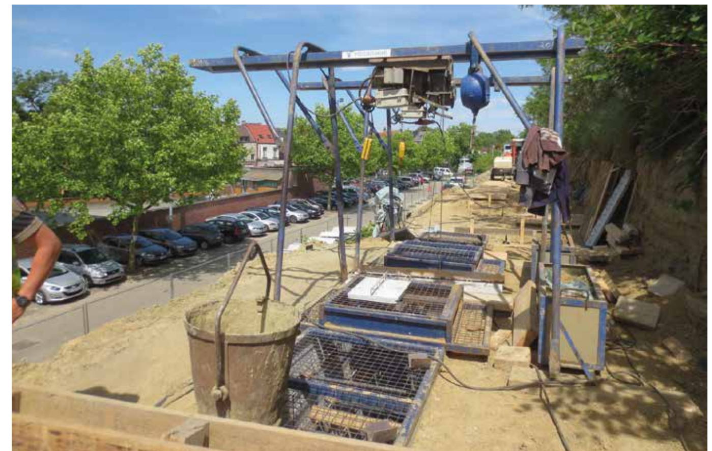
Er is geopteerd voor een uitvoering met manueel geplaatste beschoeide sleuven, met behulp van een verankeringmachine die aan de graafkraan gehangen wordt en die zo in de lucht kan werken.
