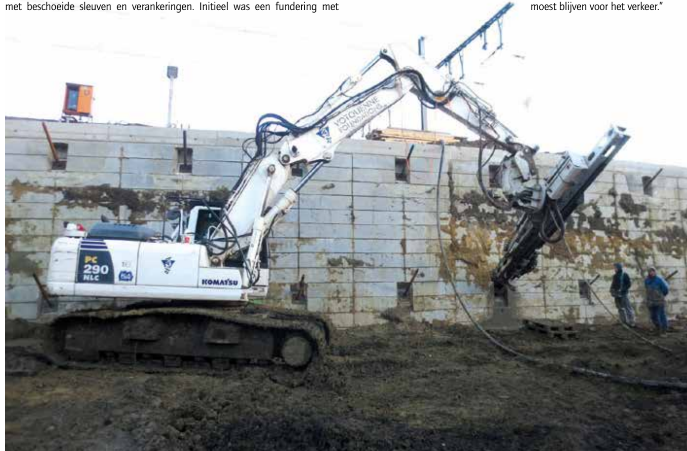
De aanleg van de nieuwe fietsostrade naast het spoor in Mechelen vereiste specifieke funderingswerken.
