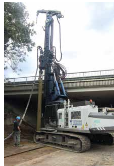
Het intrillen van profielen voor een geluidsmuur langs het spoor in het kader van de herinrichting van het station in Drongen.
