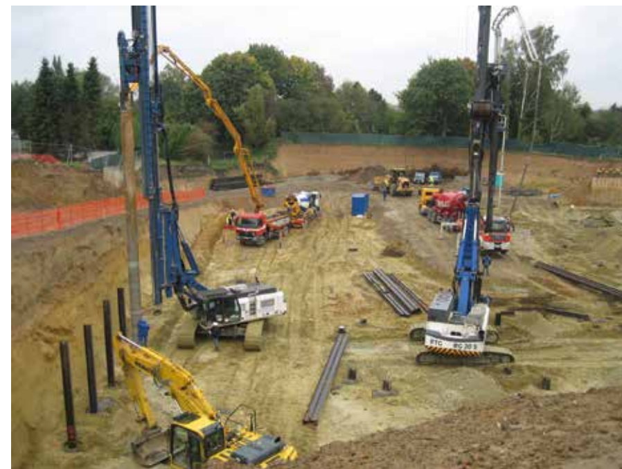
Secans- en funderingspalen voor de nieuwe parking van het station in Braine-l'Alleud.
