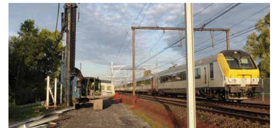
Het intrillen van profielen voor een geluidsmuur langs het spoor in het kader van de herinrichting van het station in Drongen.
