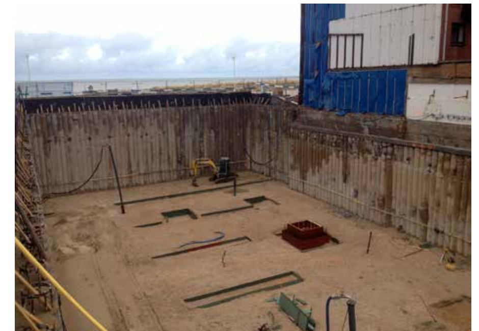
De secanspalen voor het appartementencomplex Infini in Nieuwpoort zijn met hun diepte van 14 meter een eenvoudige klus voor de LRB 355, die palen tot wel 26 meter diep kan boren.
